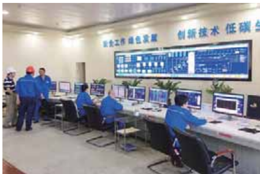
图9 改造后的辅网集控室
