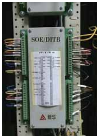
图1 改造前的端子板
