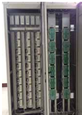
图3 改造后模块柜+端子柜示意图(正面)
